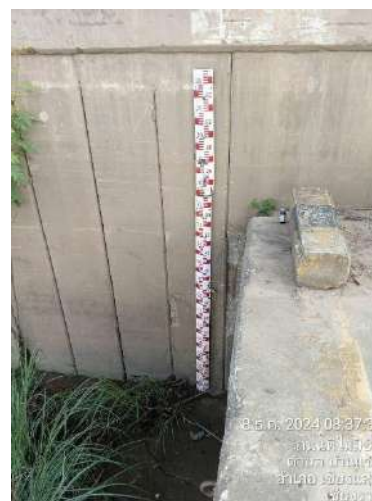
รูปที่ 4 การตรวจสอบระดับน้ำจากบรรทัดวัดระดับน้ำ
